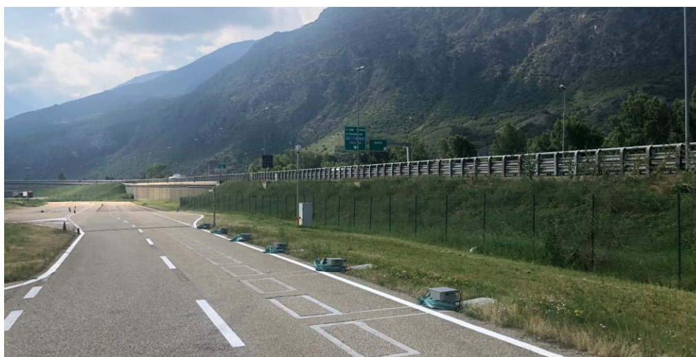
Ilustrācija 35. Bezvadu dinamiskās uzlādes projekts FABRIC Turīnā, Itālijā, izmantojot daudzus rezonatorus (2018.g)
